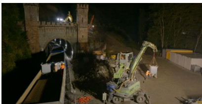
YouTube: Vorbereitungen zum Herstellen der Voreinschnittssicherung am Cramberger Tunnel (August 2023) [Quelle: DB Netz AG]
