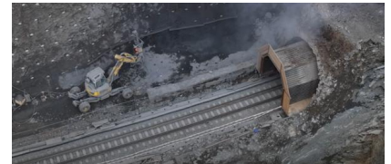
YouTube: Vorbereitung und Durchführung der ersten Lockerungssprengung für die Aufweitung des Cramberger Tunnels (Dezember 2023) [Quelle: DB Netz AG]
