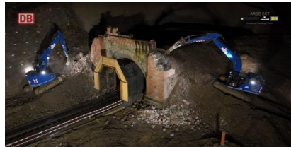
YouTube: Rückbau des Ostportals des Cramberger Tunnels (April 2024) [Quelle: DB InfraGO AG]
