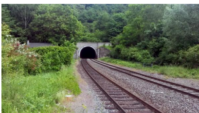
Es ist geplant, an den Portalen des Fachinger Tunnels unter anderem die Voreinschnitte anzupassen (Februar 2020) [Quelle: DB Netz AG]
